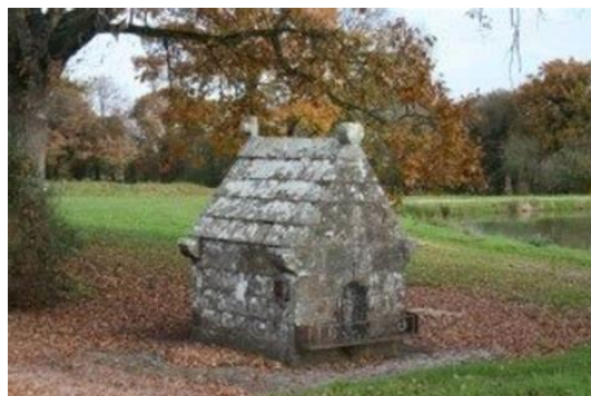
Avant la restauration
